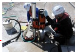
吊りコア穿孔工
