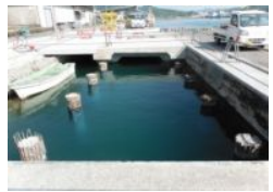
撤去完了①
