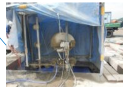
ワイヤーソー切断工
