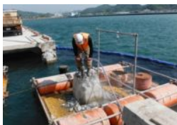
杭頭部人力破碎
