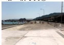
着工前写真①
