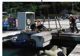
ワイヤー梁切断状況
