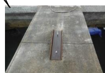
転倒防止処理
