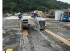
床板カッター切断状況
