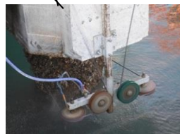
ワイヤー杭頭切断状況
