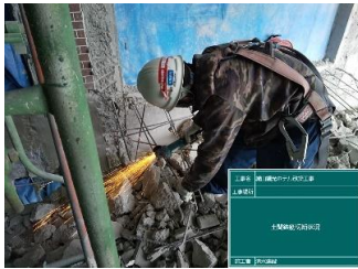
土間鉄筋切断
