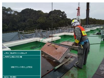
切断ブロック撤去
