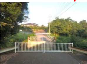
撤去完了(上部工)
