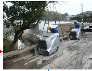
床版カッター工(地覆)
