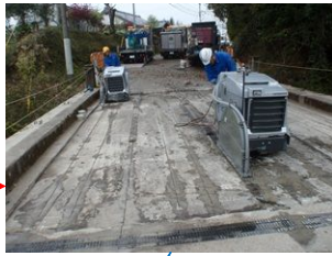
床版カッター工
