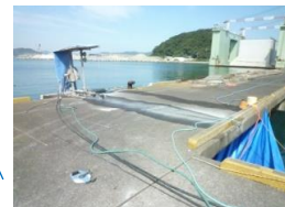
ワイヤーソー切断工
