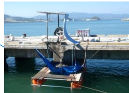
ワイヤーソー切断工
