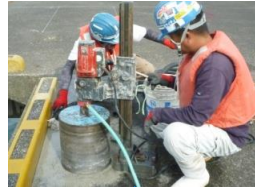
吊りコア穿孔工
