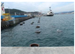
栈橋撤去完了
