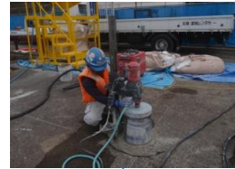
吊りコア穿孔工
