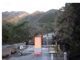
上部工撤去完了
