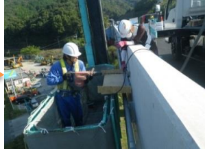
アンカー設置
