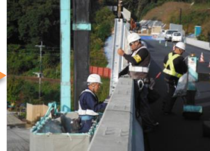
遮音板設置 (支柱取付)
