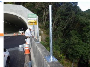
落下防止柵設置
