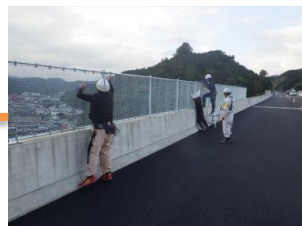
落下防止柵設置
