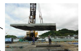
床板撤去状況
