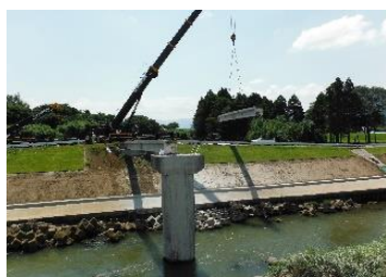
桁上床板撤去完了
