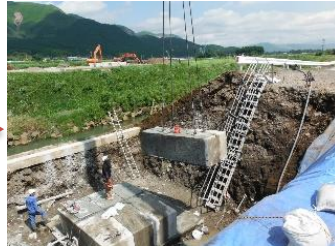
桁上床板撤去
