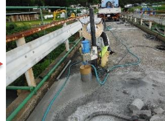
床板撤去(コア削孔)
