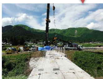
桁上床板撤去完了
