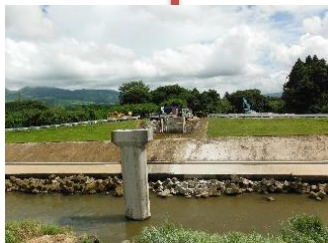
床板撤去完了
