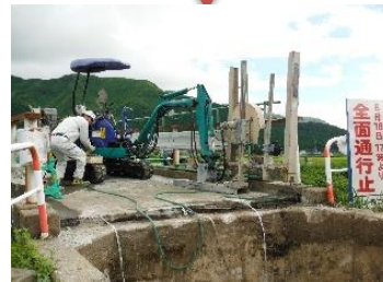
床板カッター切断
