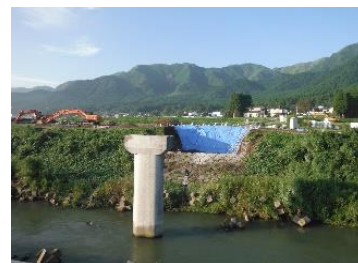
桁上床板撤去完了
