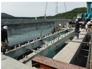
鋼桁撤去
