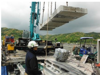
地覆・床板撤去
