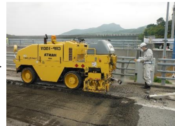
アスファルト舗装板切削
