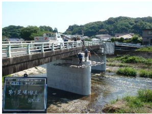
土嚢・足場撤去
