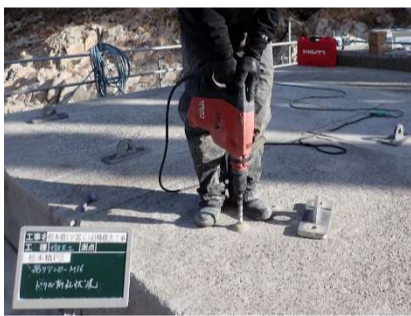
アンカー用削孔
