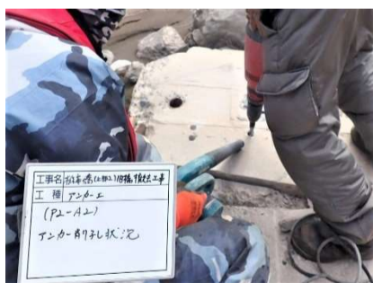
アンカー用削孔
