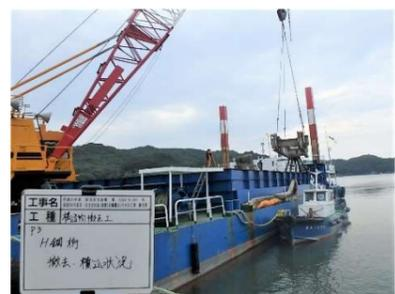
⑥ 床版切断・撤去（水中ワイヤーソー切断）
