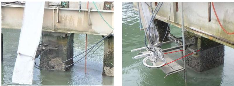
③ 橋脚切断・撤去（アンカー）施工状況
