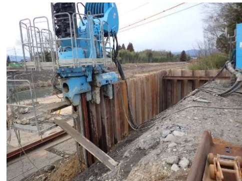
パイロオーガー併用圧入施工
