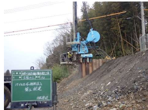
パイロオーガー併用圧入施工
